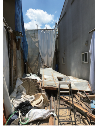
解体中の様子です
